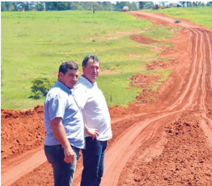
O prefeito Hermes Pimentel e o vereador Fernando Galmassi visitaram o canteiro de obras da pavimentação da Estrada Canelinha
