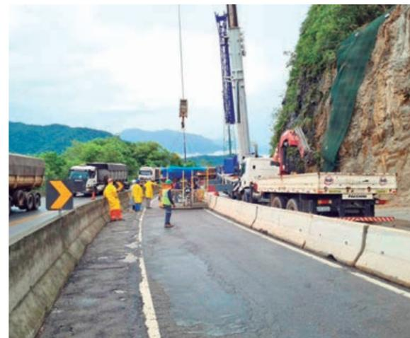
Os esforços no local estão concentrados na perfuração do maciço rochoso e instalação de tela metálica de alta resistência
