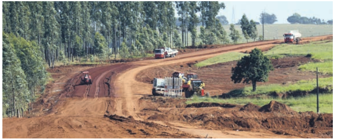
O tráfego está fluindo de forma improvisada, por desvios laterais, e quem passa pelo local se impressiona com o rápido andamento das obras
