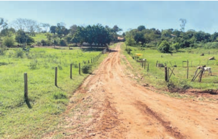
Essa é a rua Leovaldo Bento que será pavimentada em Esperança Nova
