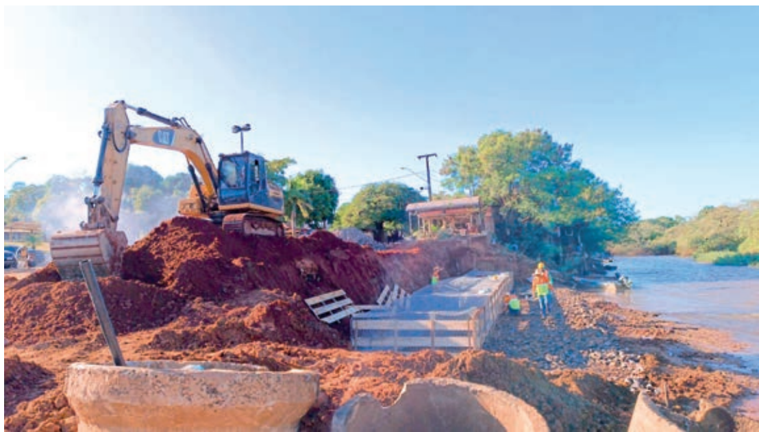
As obras da nova rampa estão a todo vapor em Porto Camargo
