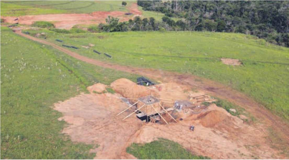
A estrutura de abastecimento de Umuarama passa por uma renovação
