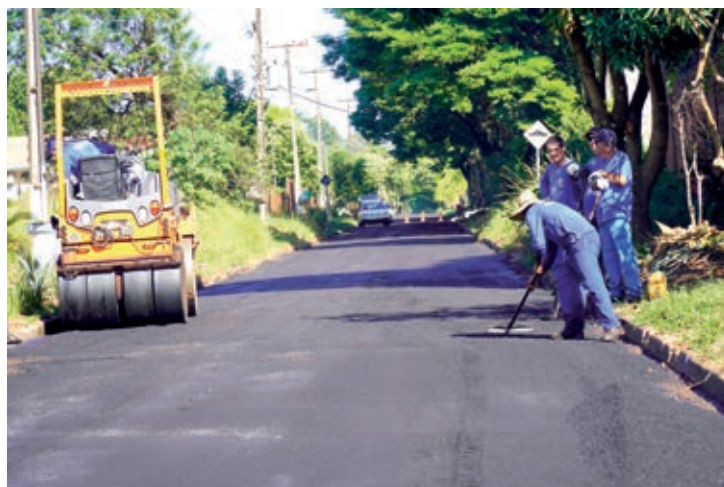
O serviço de micropavimentação para recuperação do pavimento asfáltico executado pela Prefeitura de Umuarama está avançando na região do Jardim São Cristóvão
