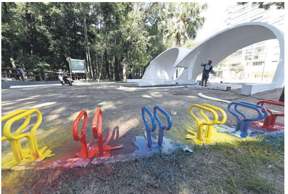
O trabalho, que foi determinado pelo prefeito Hermes Pimentel, compreende a recuperação da pista de caminhada, com eliminação de buracos e outras imperfeições, a pintura entre outras
