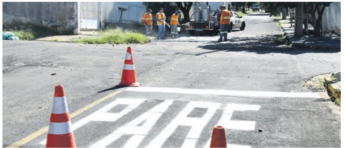
A obra mais significativa seja talvez o recapeamento do último trecho da avenida Vitória que ainda não recebeu melhorias estruturais
