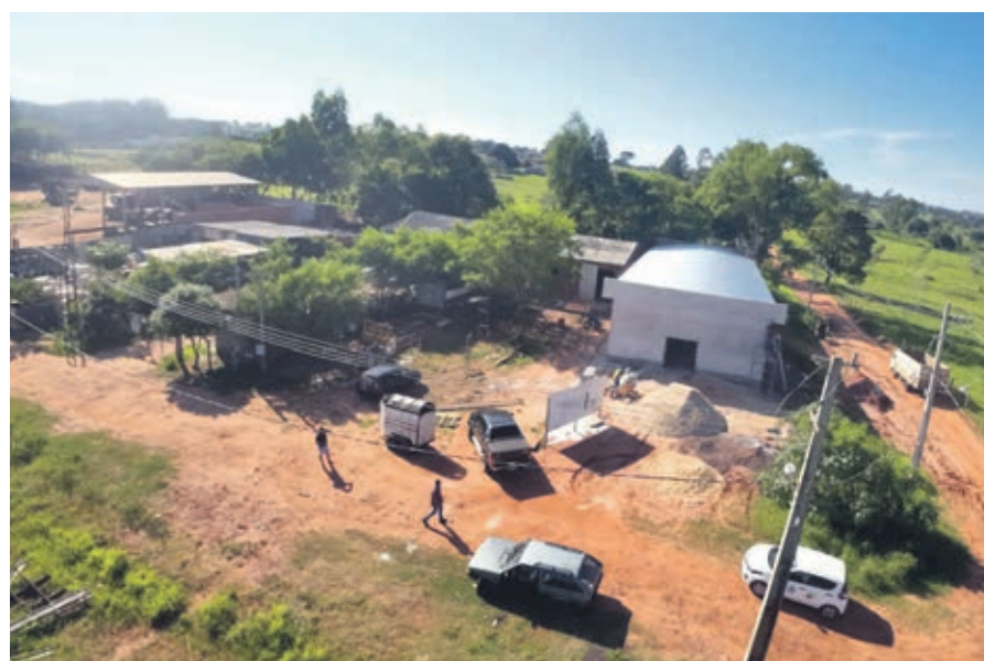
Barracão Industrial em construção
