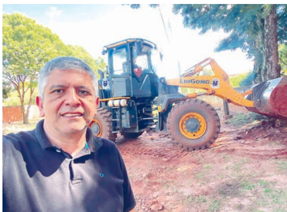
Prefeito Giovane Mendes acompanha de perto o andamento das obras
