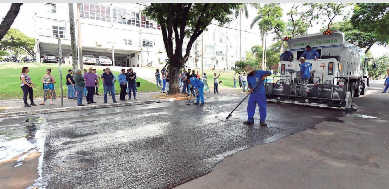
**PIMENTEL APRESENTA CAMINHÃO/USINA DE PAVIMENTO** - O prefeito de Umuarama, Hermes Pimentel apresentou ontem a mais nova aquisição do município para intensificar a recuperação do asfalto. É um caminhão bitruck acoplado com usina de micropavimentação asfáltica, adquirido com o investimento de R\$ 1,7 milhão. Página A5
