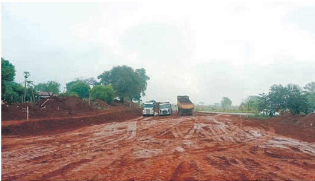
Mesmo com chuva, máquinas trabalham no avanço das obras
