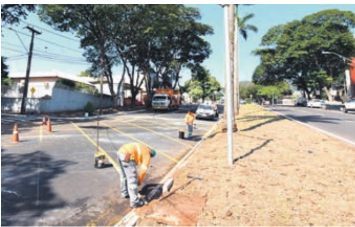
O canteiro central foi estreitado em cerca de 150 metros, iniciando no final da avenida 19 de Dezembro
