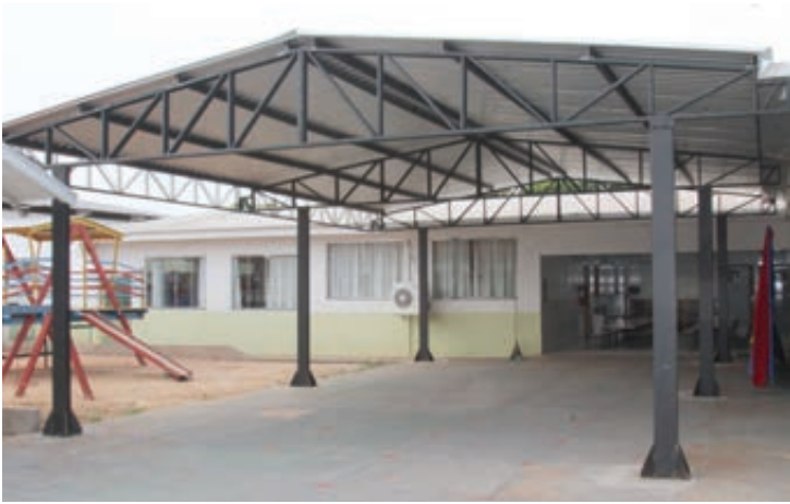
Obra está na fase final em Perobal
