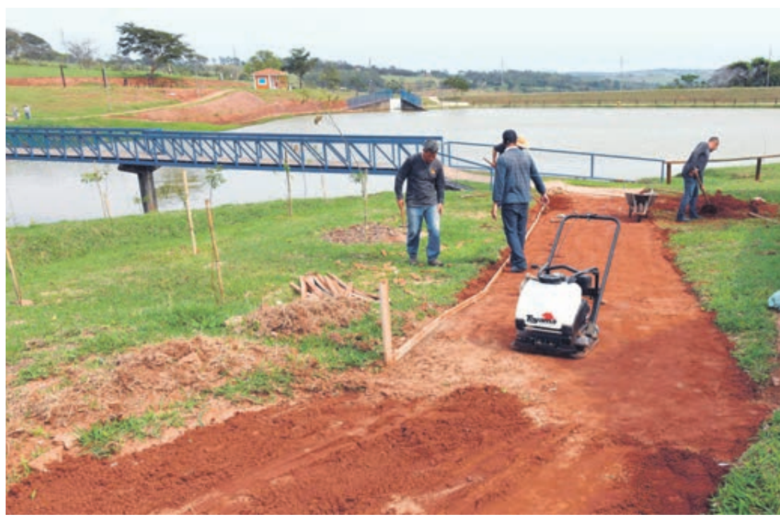
Os serviços são executados sob a supervisão da Secretaria de Obras, Planejamento Urbano e Projetos Técnicos
