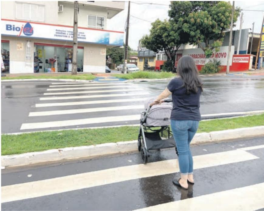
Ao longo da faixa de pedestre, mesmo com as guias rebaixadas nas calçadas, no canteiro central não foram realizados os rebaixamentos para passagem
