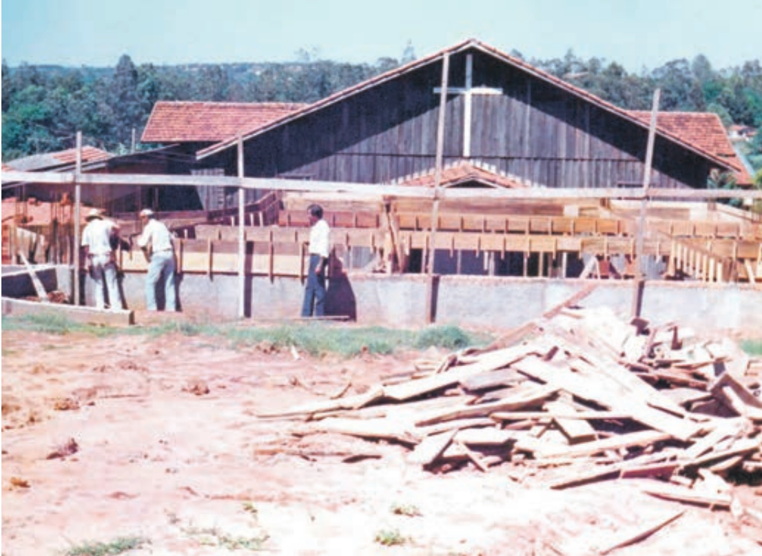
Início da construção da nova igreja e aos fundo a capela de madeira construída em 1977
