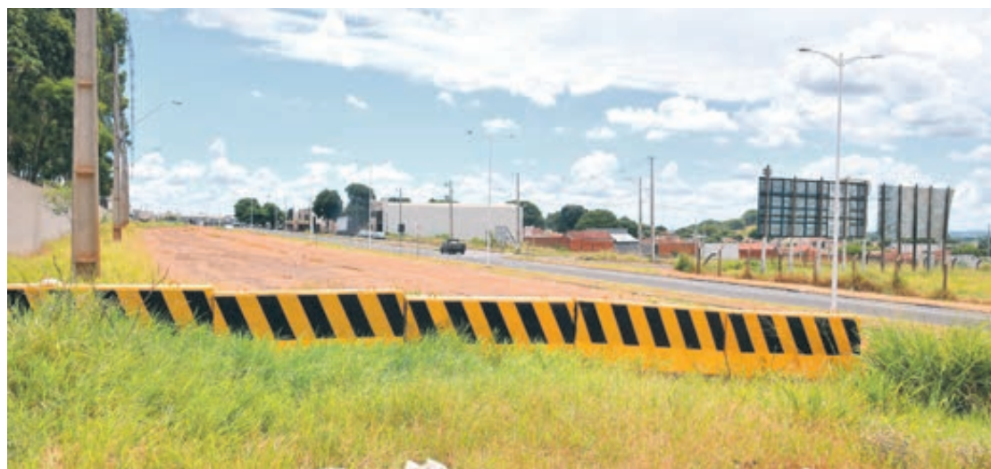
O entrave ocorreu no trecho final, após a execução de 92% do projeto, quando a Mitra Diocesana entrou na Justiça e conseguiu liminar impedindo a conclusão da obra numa extensão de 180 metros
