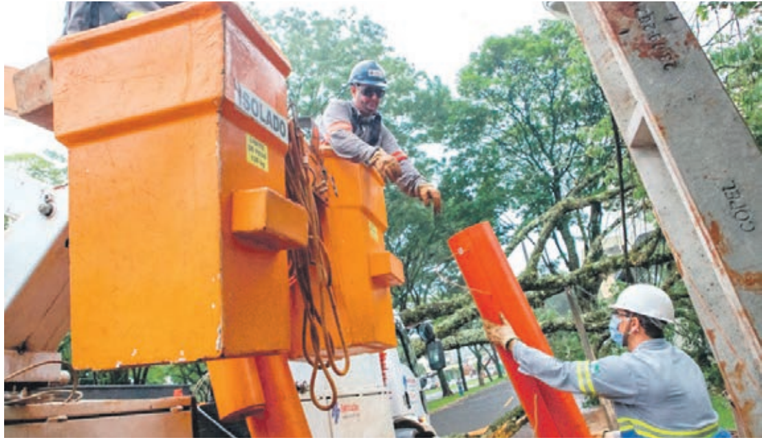
Para agilizar o serviço, em alguns casos as equipes estão instalando postes de fibra de vidro, mais leves, para facilitar a reconstrução
