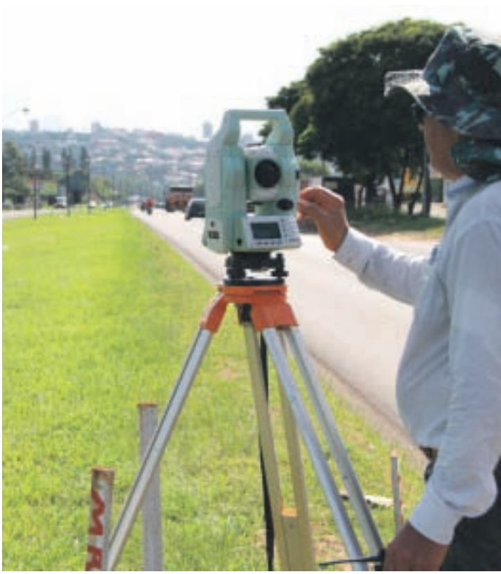
O DER/PR confirmou o início dos serviços de topografia e a instalação do canteiro de obras da empresa que irá realizar a execução das terceiras faixas da rodovia PR-323
