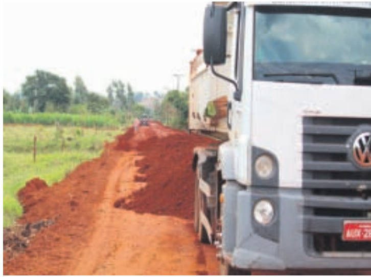
Melhorias das estradas rurais, ruas e avenidas têm sido uma constante no município
