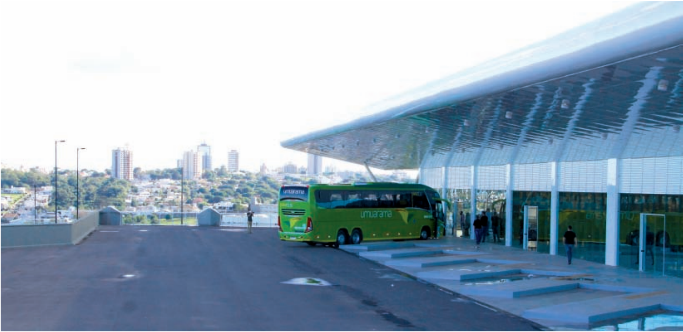
A nova estação rodoviária entrou na reta final da construção e até outubro deve ser entregue à população
