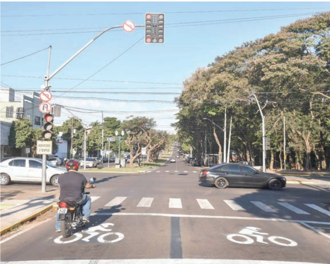
O espaço é demarcado por uma segunda linha de retenção, pintada poucos metros antes da linha que delimita o espaço entre os veículos e a faixa de pedestres
