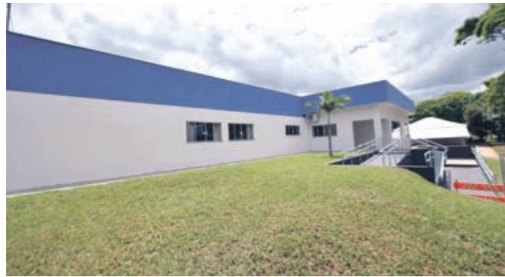
O serviço foi iniciado no ano passado com o investimento de R$ 395,5 mil em recursos próprios e incluiu reforma da fachada, pintura, piso e melhorias nos ambientes
