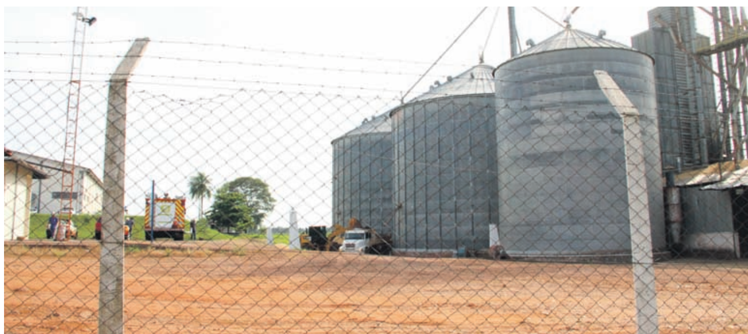
Silos e armazéns são centros de grandes acidentes do trabalho, por serem caracterizados espaços confinados, lugares fechados, enclausurados, perigosos e traiçoeiros
