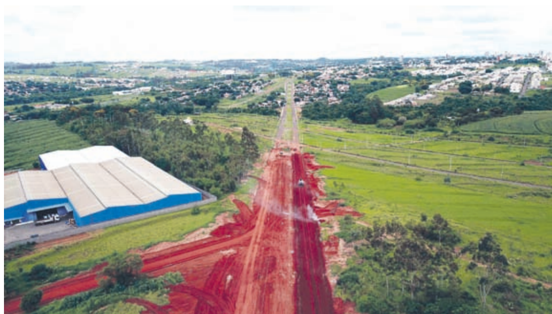
Uma frente de trabalho está executando o calçamento nas laterais da avenida e o plantio de faixas de grama
