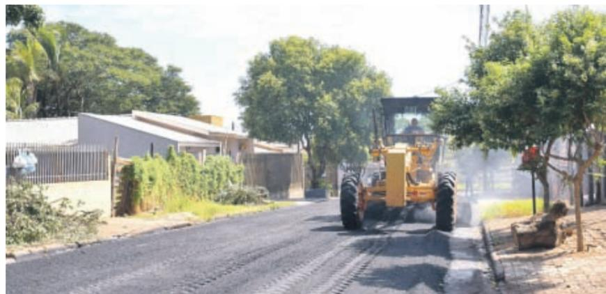
O reperfilamento corrige imperfeições onde o pavimento asfáltico está mais desgastado
