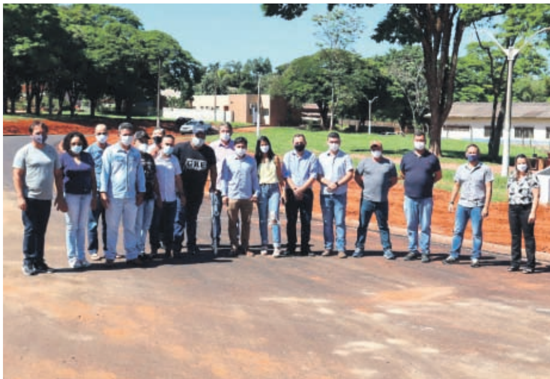
Verificação da pavimentação na praça do Jangada. Prefeito Juninho, primeira-dama Rafaela e vice Minoru, vereadores e secretários
