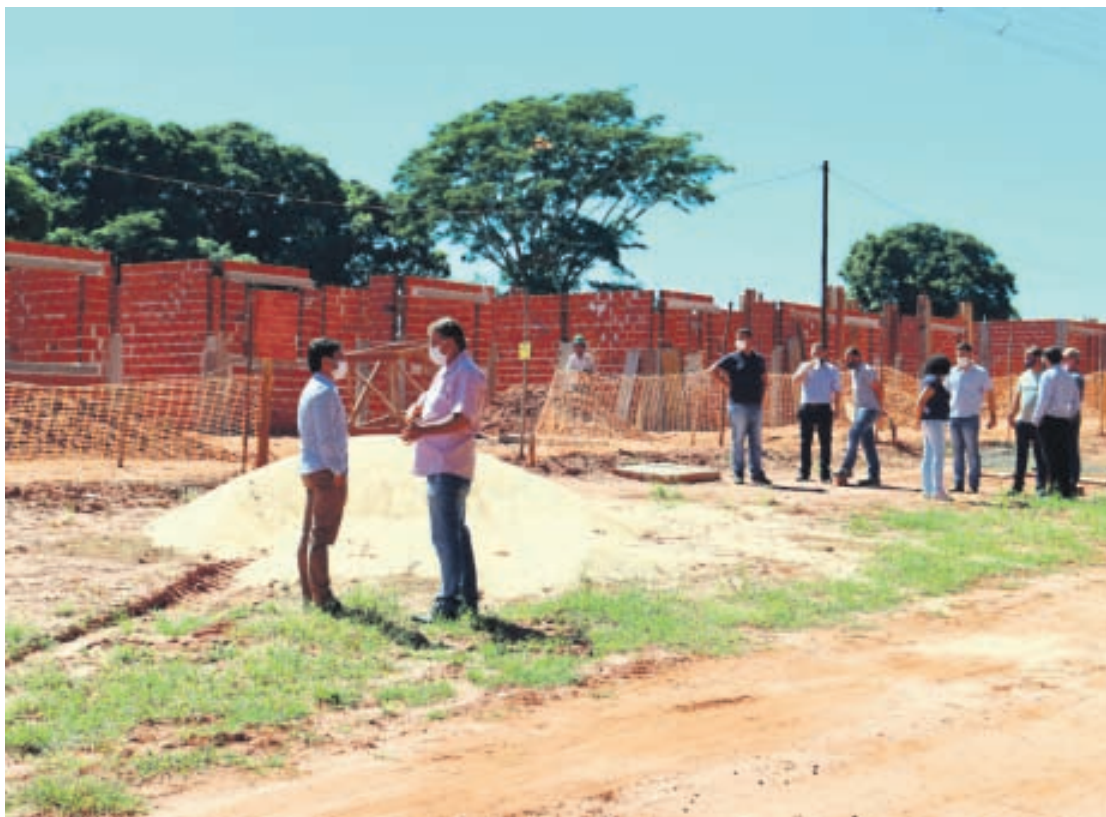
Visita nas 10 casas populares em construção no distrito de Jangada
