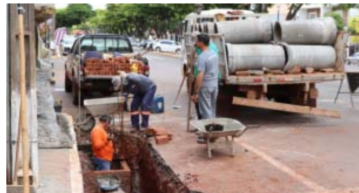
Obras melhoram a infra-estrutura no centro de Guaira
