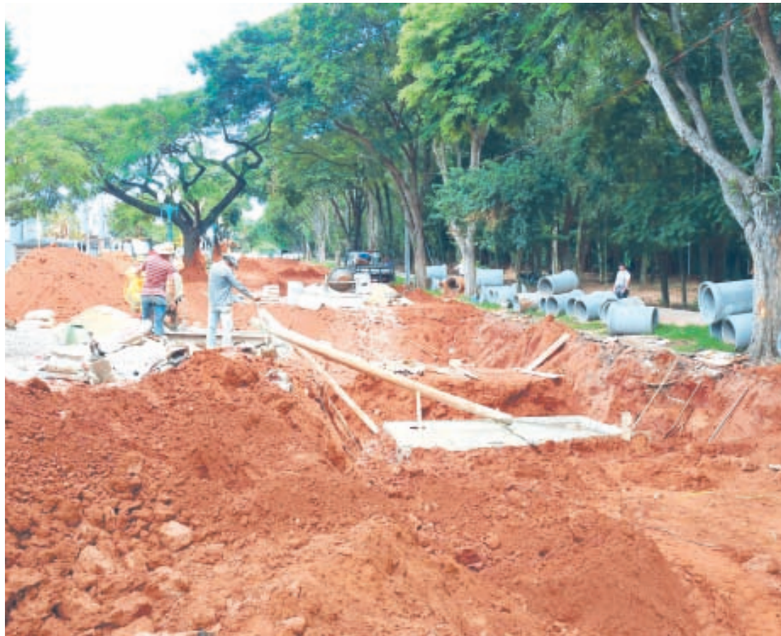
Parte mais volumosa do trabalho já foi cumprida, com a instalação de cerca de 400 metros de galeria dupla com tubos de 1,20 de diâmetro
