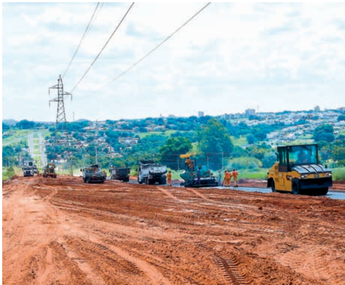
Obras na avenida avançam e caminham para a fase final
