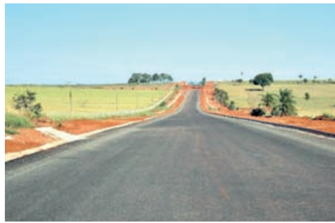
A pavimentação da Boiadeira já ocorre entre Icaraíma e Santa Eliza
