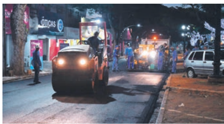
A melhoria também atendeu uma parte do entorno da Praça da Bíblia e do camelódromo, seguindo até o primeiro retorno da principal avenida de Umuarama
