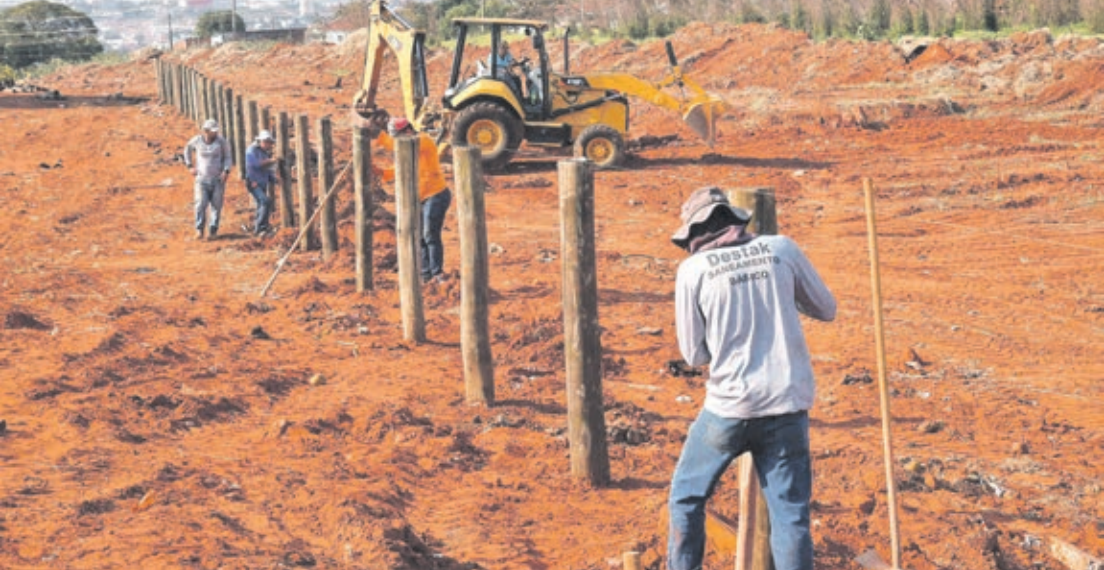
Operários trabalham na construção da cerca no aeroporto
