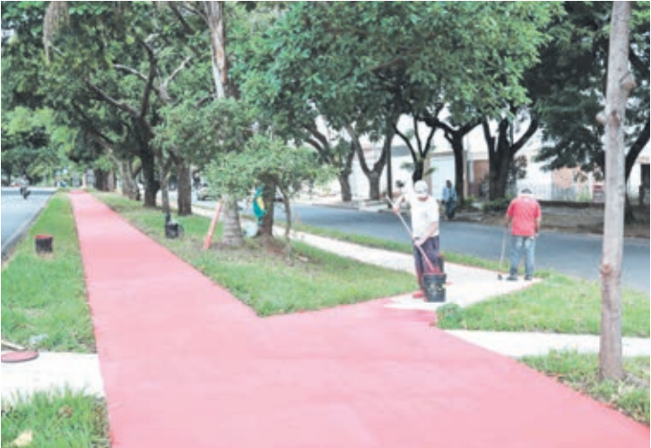
A obra está mais adiantada entre a Praça Tamoio e as saídas para Serra dos Dourados e Maria Helena
