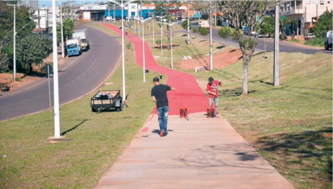
A pintura esta sendo realizada na ciclovia na avenida Angelo Moreira da Fonseca
