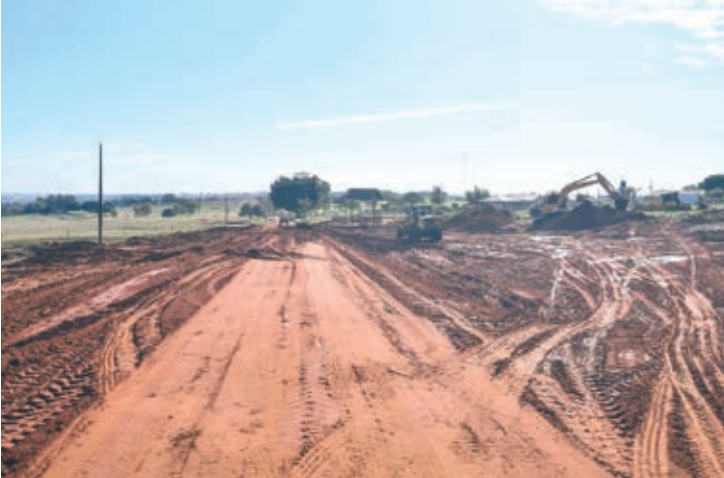
Máquinas ampliam recuperação de estradas rurais em Umuarama
