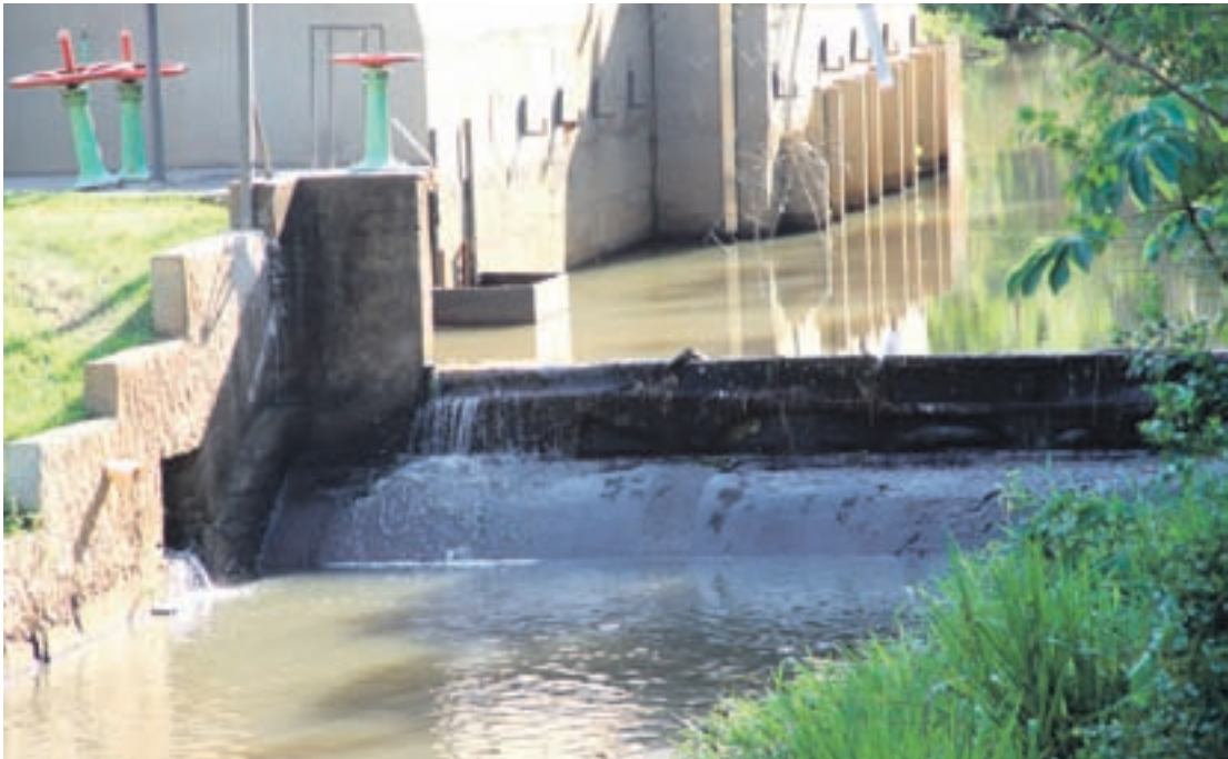
No fim da tarde de ontem, a vazão do rio pouco ultrapassava a barragem da captação de água da Sanepar
