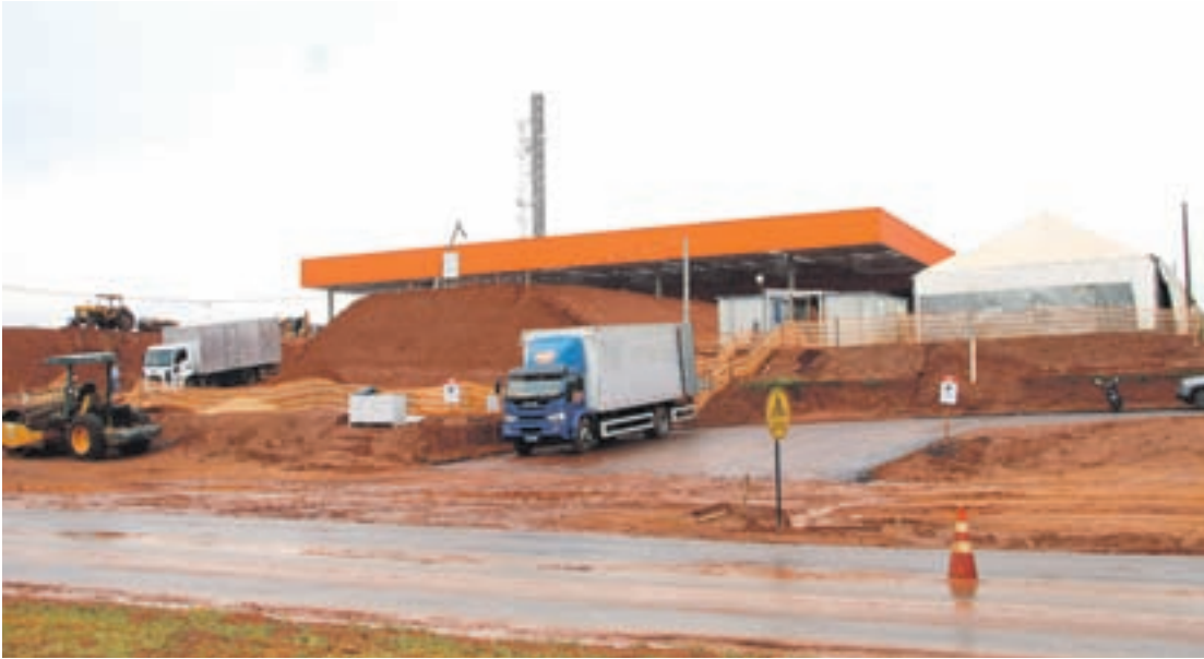
Estrutura do Atacadão de Umuarama começa a tomar forma em ritmo acelerado
