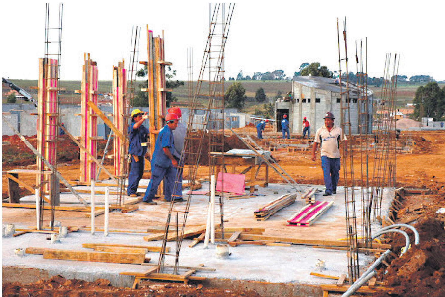
Construção Civil continua forte na economia de Umuarama
