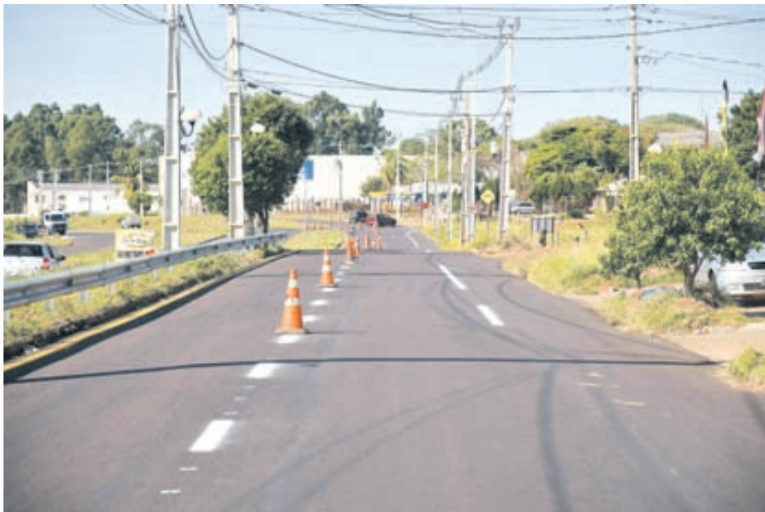
O serviço faz parte do contrato de construção da nova via urbana e é executado pela empresa responsável pela obra
