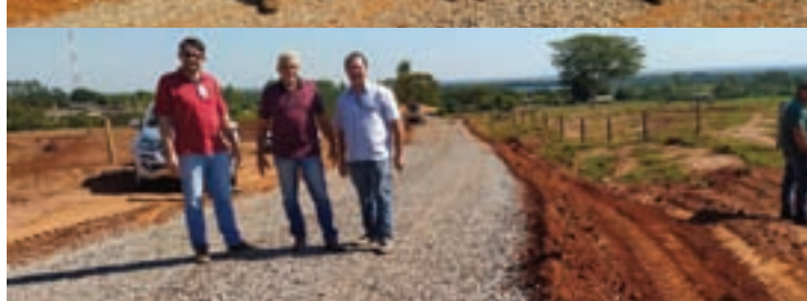
Gervasone acompanhado de técnicos e assessores na visita às obras
