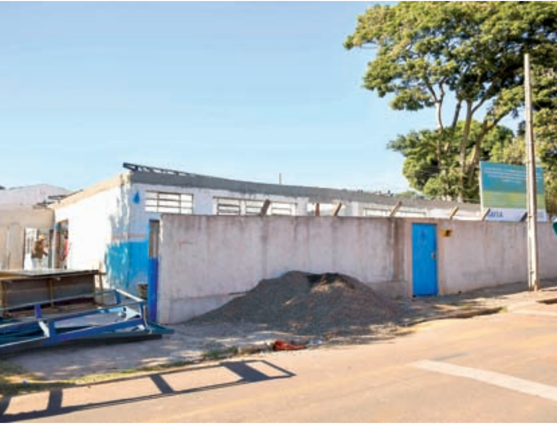
Na Escola Municipal Dr. Ângelo Moreira da Fonseca, no Parque Dom Pedro, a Prefeitura está construindo seis novas salas de aula
