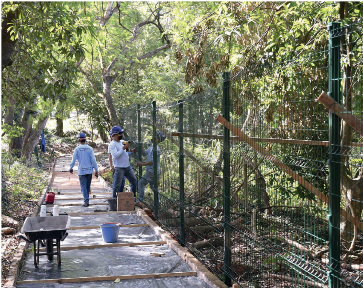
Grade está sendo instalada na margem da pista de caminhada dentro do bosque
