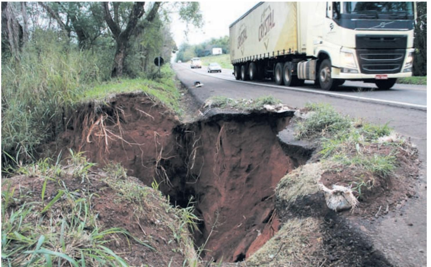
Segundo o DER/PR, uma empresa já foi contratada para realizar os serviços de recuperação de aterro e execução de bueiro metálico pelo método
