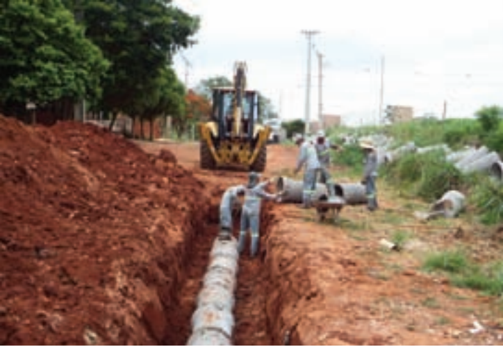
Operários trabalhando na execução da obra
