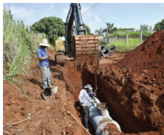
Foram implantados cerca de 200 metros de galerias com tubos de 0,60m de diâmetro, 8 bocas de lobo e quatro poços de visita
