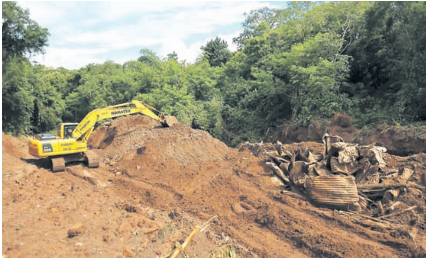
Máquina trabalha no início da obra no interior do bosque
