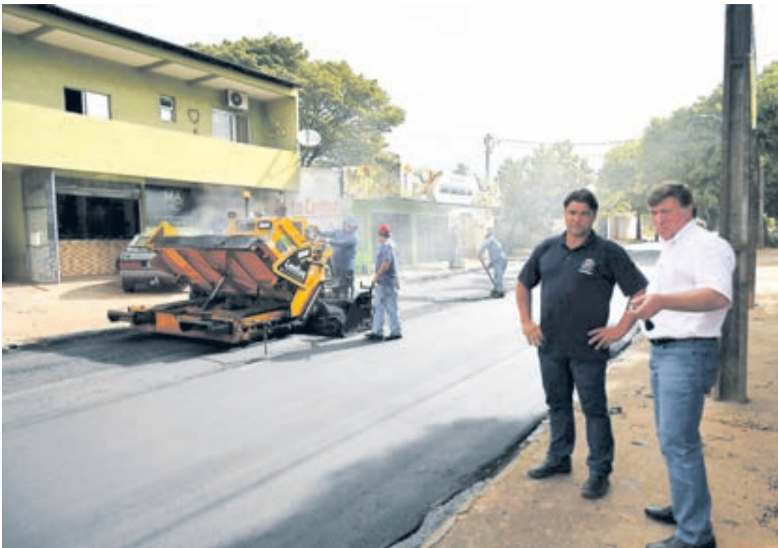
Prefeito Celso Pozzobom acompanhou o andamento da obra
