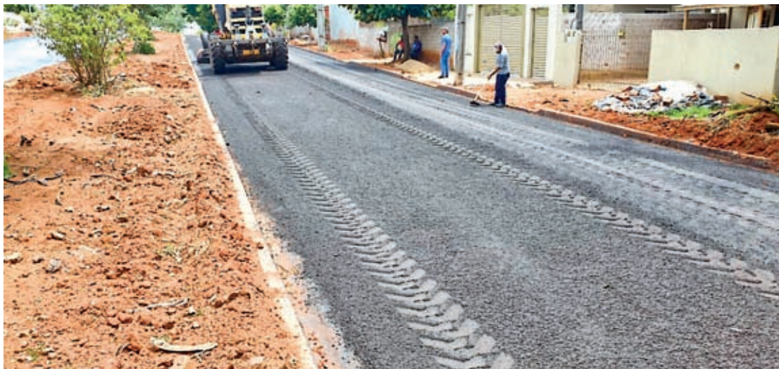
Pavimentação asfáltica de qualidade em novas vias
