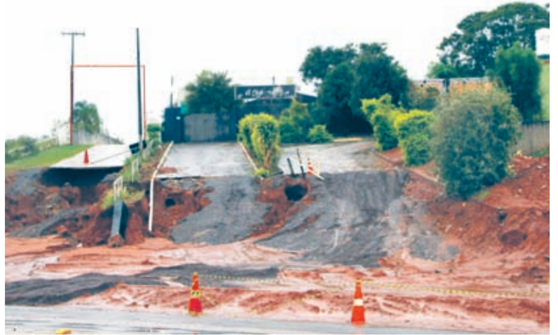
Com o desabamento o acesso principal a chácaras e a um motel ficou prejudicado. Prefeitura construiu acesso secundário nas proximidades
