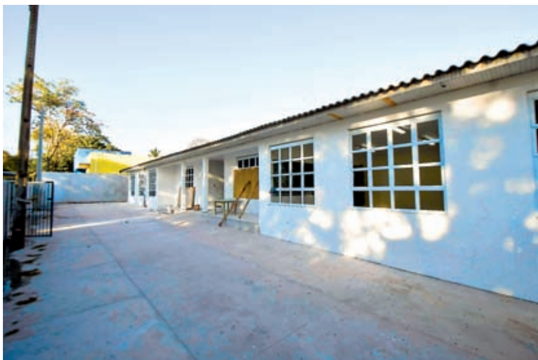
Enquanto não tem aulas presenciais, avançam as obras na escola
