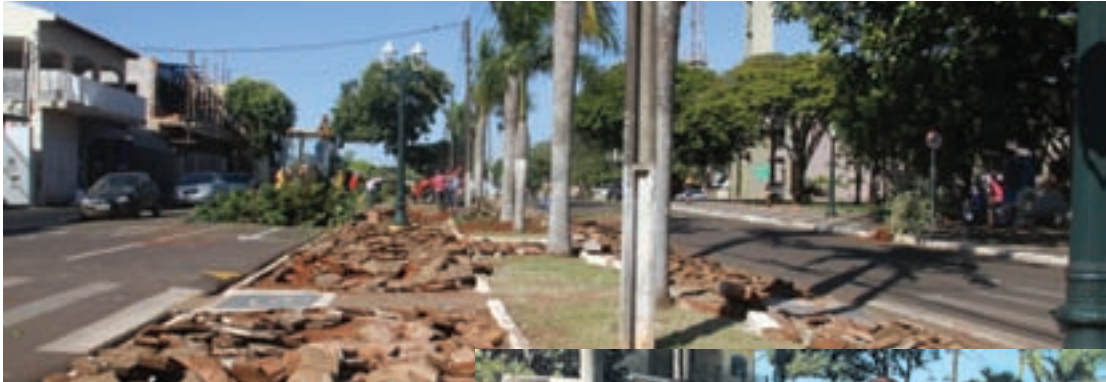
Operários trabalhando no início da obra
