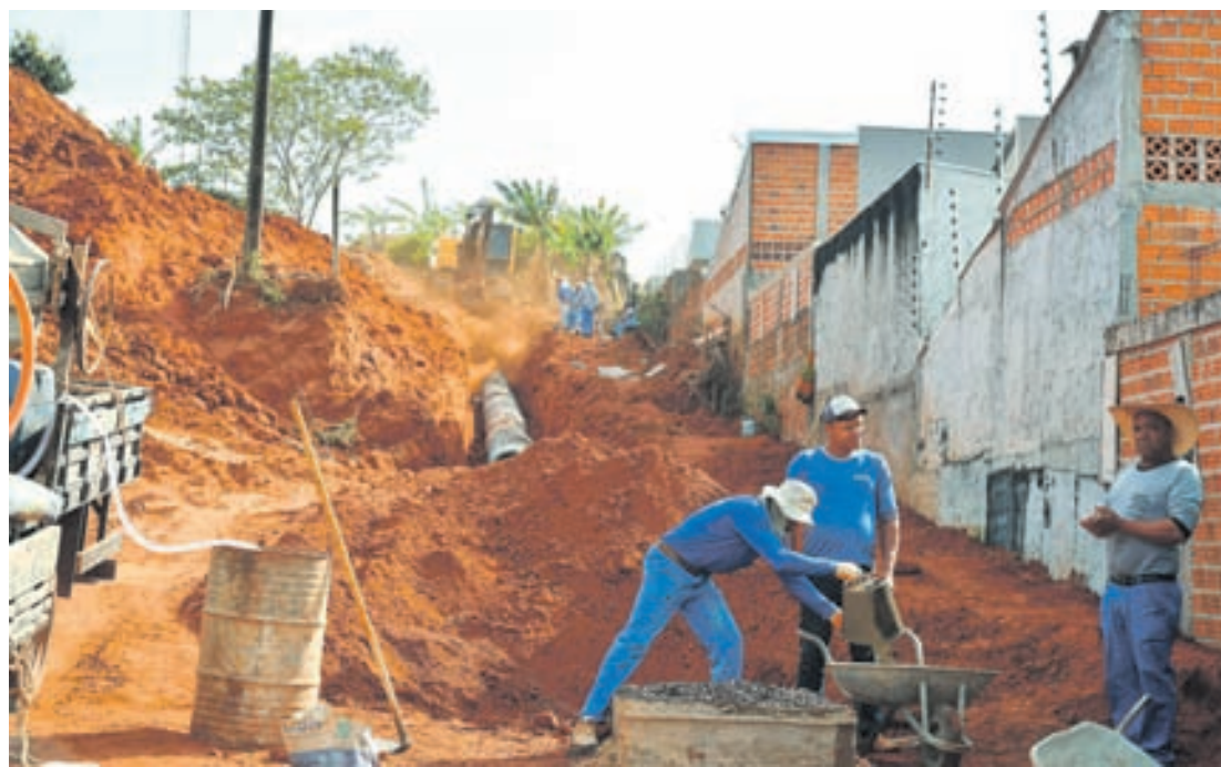
No local será implantado um ramal de galerias pluviais para eliminar um antigo ponto de alagamento
