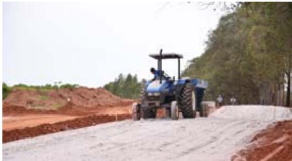
Na Estrada Pioneiro, a capa asfáltica a ser utilizada será o tratamento superficial triplo (TST)
