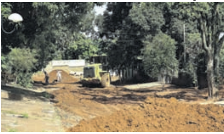
A última etapa do trabalho será a pavimentação das ruas escavadas e da nova travessa, aberta entre a avenida e a Rua Bararuba
